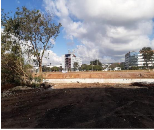
Descrição: Acesso 3- Estaca 229 em 22/09/2022
