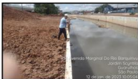
Foto 3 - Procedimento de monitoramento e medição de campo do parâmetro Turbidez - Ponto 03.
