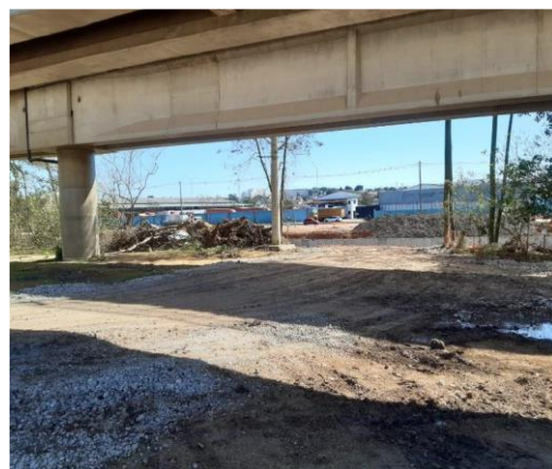
Descrição: Acesso 8- Estaca 195 em 15/02/2023
