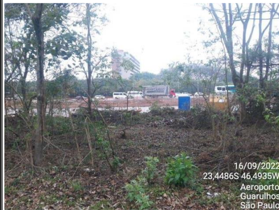
Descrição: Acesso 14 - Estaca 168 em 16/09/2022
