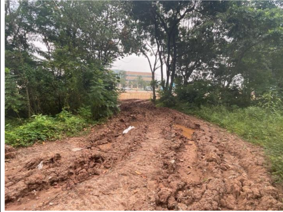
Descrição: Acesso 11 - Estaca 181 em 15/02/2023
