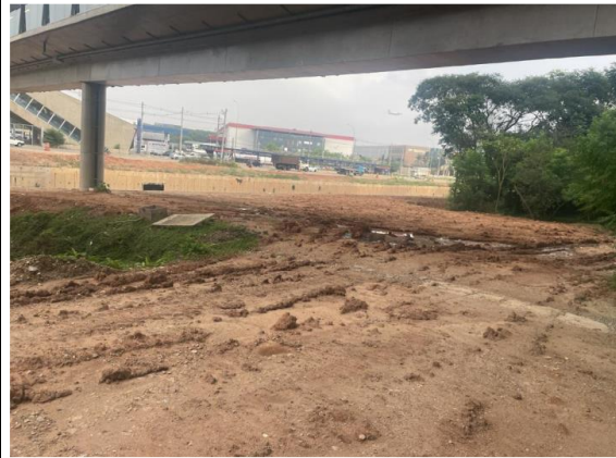
Descrição: Acesso 12- Estaca 173 em 15/02/2023
