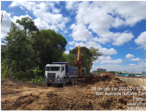
FOTO 7 – CARREGAMENTO DE MATERIAL
