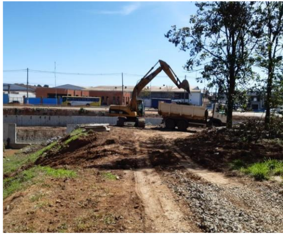
Descrição: Acesso 7 - Estaca 198 em 22/09/2022- Acesso existente
