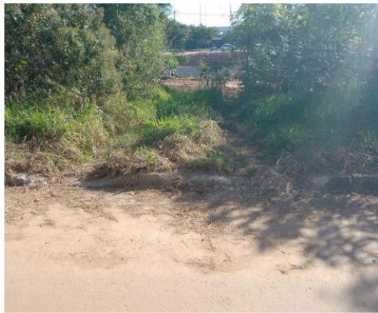
Descrição: Acesso 4- Estaca 225 em 13/09/2022
