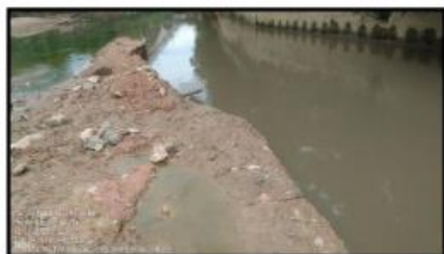
Imagem 2 - Ensecadeira de terra no Rio Baquirivu-Guaçu - Porção montante ao Ponto 05 de Monitoramento.
