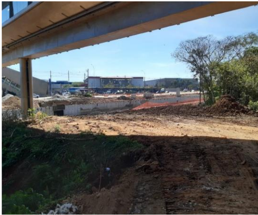
Descrição: Acesso 12 - Estaca 173 em 13/09/2022
