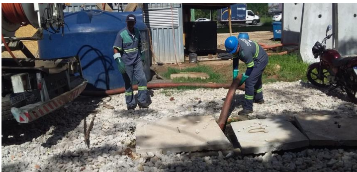
FOTO 3 – LIMPEZA DA FOSSA SÉPTICA
