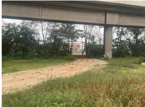
Descrição: Acesso 9 - Estaca 189 em 15/02/2023
