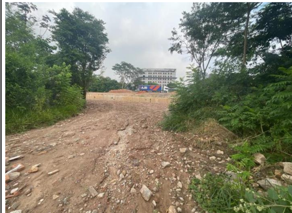
Descrição: Acesso 4- Estaca 225 em 15/02/2023
