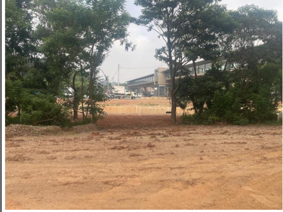
Descrição: Acesso 13 - Estaca 170 em 15/02/2023
